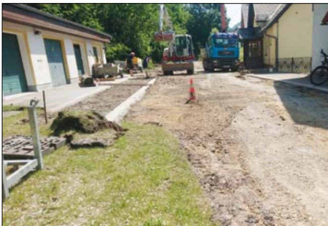
Bauarbeiten in der Zufahrt Lechner-Bigl und am Kirchenplatz
